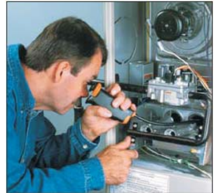
Inspection d'endroits difficiles d'accès sur une chaudière.
