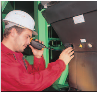
Recherche rapide de conduits de climatisation bouchés
